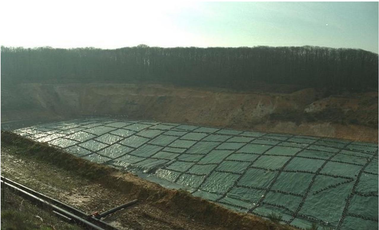
Figure 2. Couverture intermédiaire avec lestage
