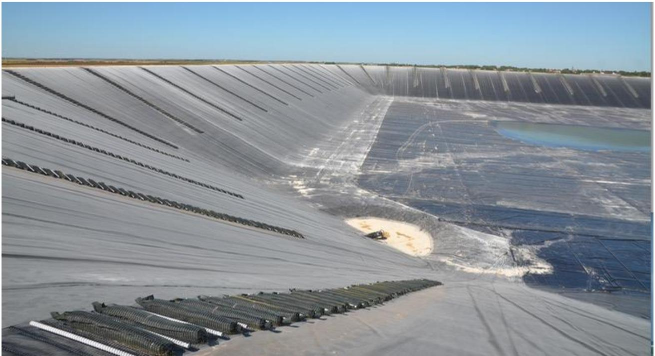
Figure 15. Lestage papillotes horizontales sur une Géomembrane
