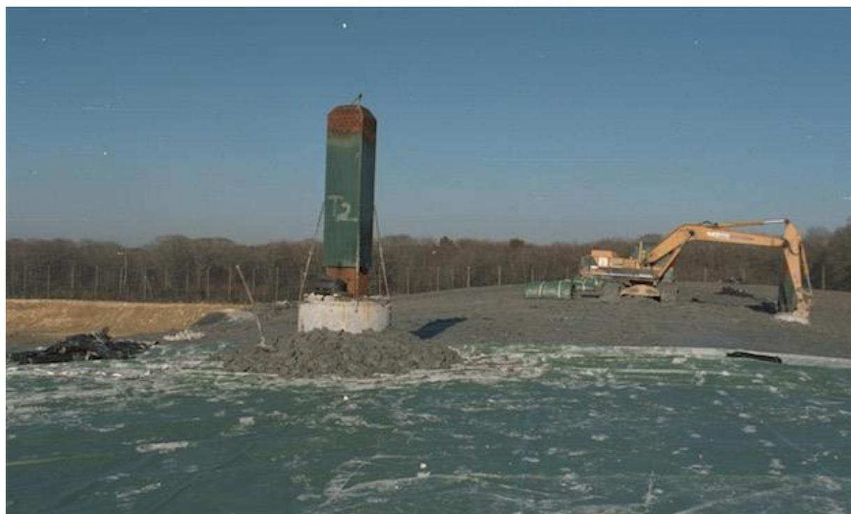
Figure 4. Mise en place de matériau granulaire sur un Géofilm armé
