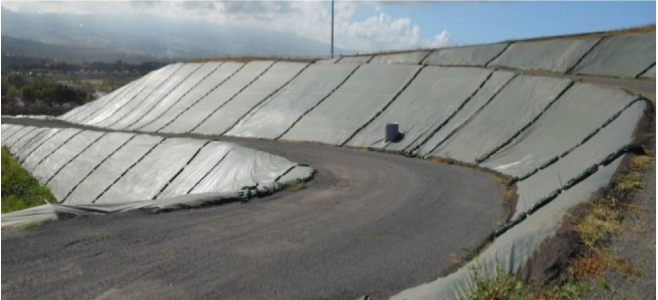
Figure 14. Lestage papillotes verticales sur les talus d'un ISDND
