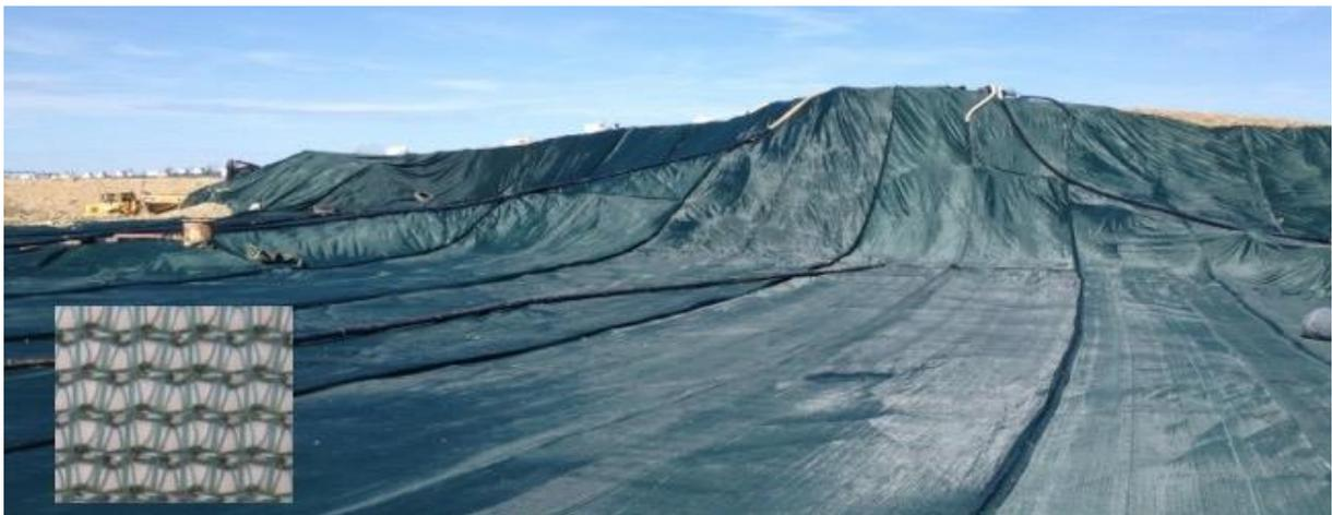
Figure 13. Lestage par filet d'un géofilm armé – raccordement par couture des lés du filet
