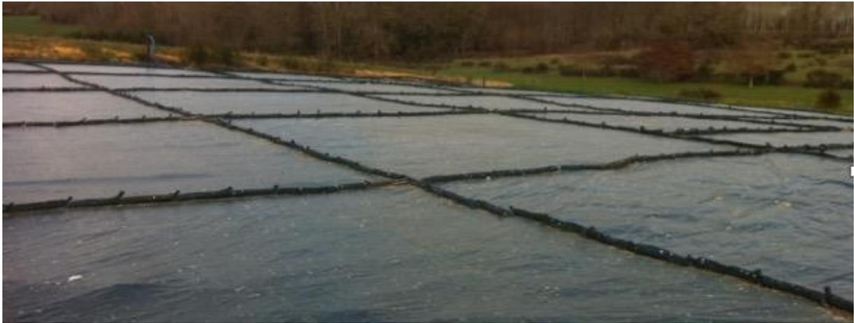
Figure 12. Lestage à plat, par sacs, en partie courante
