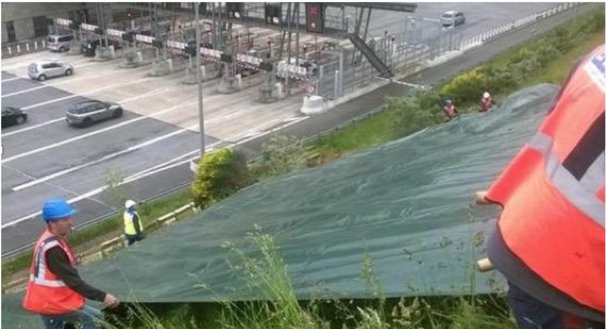
Figure 10. Mise en place d'une protection de talus
